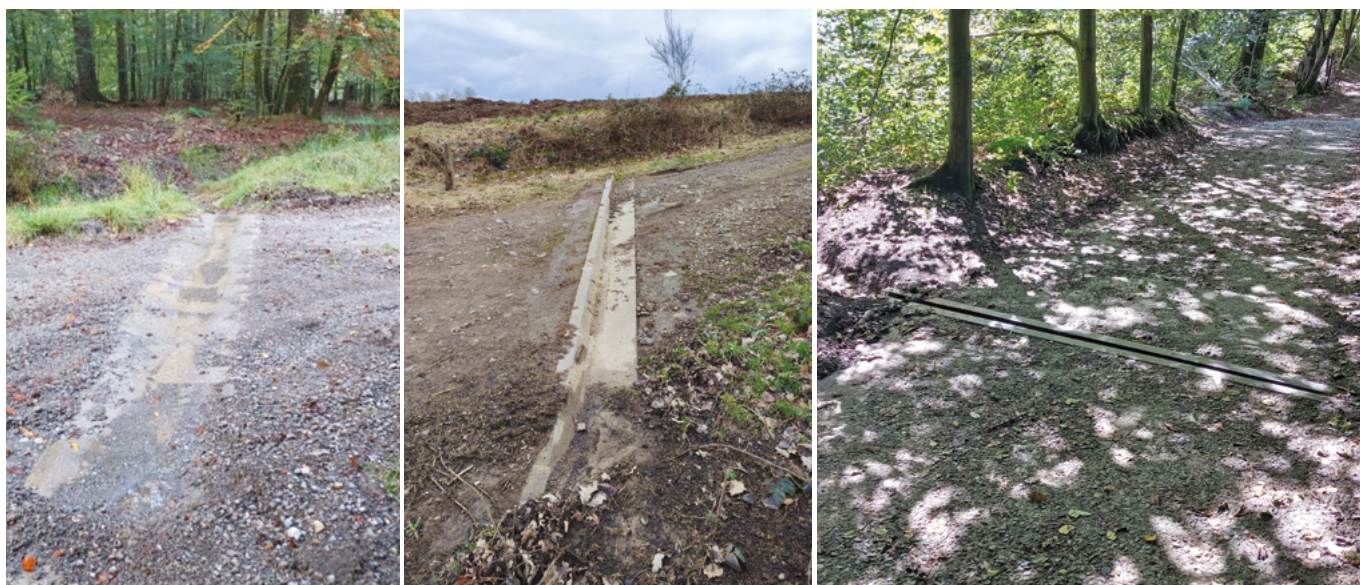
Figure 12. À gauche, filet d'eau de type rigole © Contrat de Rivière Lesse, le 20 janvier 2025 au bois de Bande - Nassogne. Au centre, filet d'eau de type bordure © Contrat de Rivière, le 12 mars 2025 à Roy - Nassogne. A droite, filet d'eau de type rail © Contrat de Rivière Dyle-Gette au Bois de Lauzelle à Ottignies-Louvain-la-Neuve, 2024
