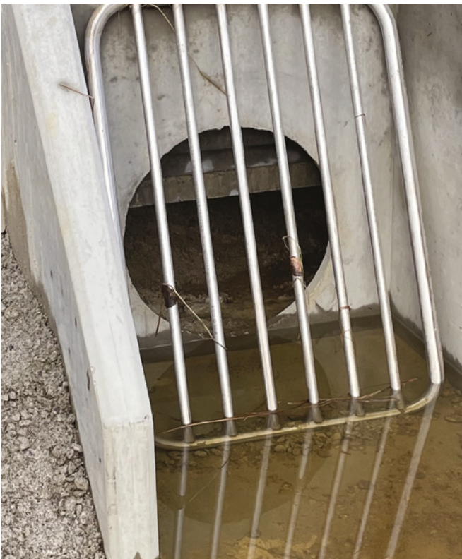
Figure 14. Grille anti-embâcles disposée devant un pertuis. © Contrat de Rivière Lesse le 11 octobre 2024 au bois de Bande - Nassogne.
