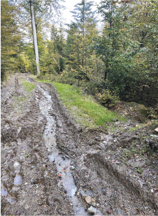
Figure 9. Dégradation du chemin forestier au bois de Bande à cause du ruissellement emportant les sédiments © Contrat de Rivière Lesse le 11 octobre 2024.
